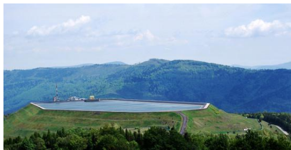
Góra Żar - elektrownia szczytowo-pompowa
