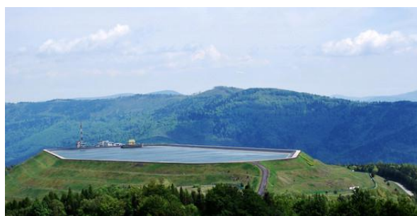
Góra Żar - elektrownia szczytowo-pompowa
